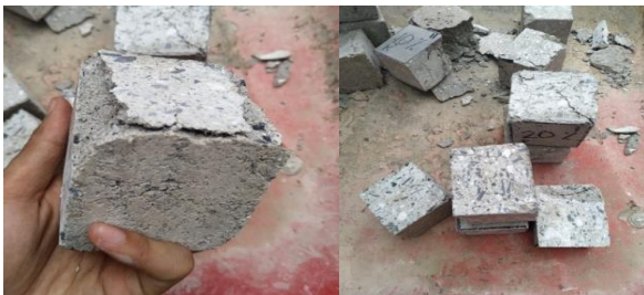
Gambar 3. Pola Retakan Paving Block
