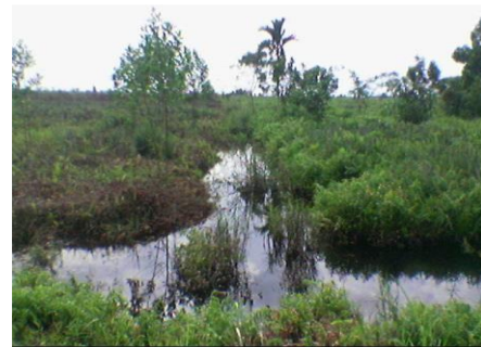
(1) Saluran Tersier-14 Tersumbat Akibat Sedimentasi
