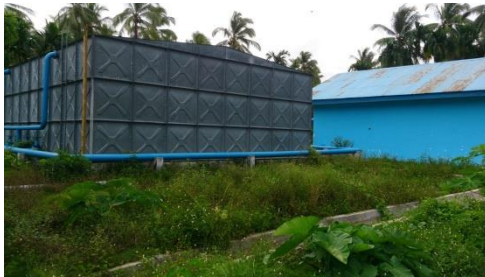
Gambar 5.11 bangunan bak Reservoir (Dokumentasi Lapangan)
