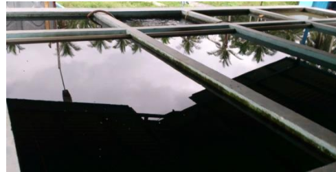
Gambar 5.9 Bak Sedimentasi (Dokumentasi Lapangan)
