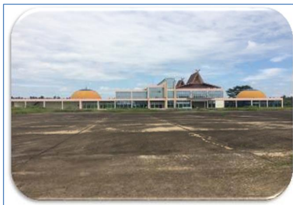
Gambar 3. Bandara Tempuling Sumber : Survey Lapangan, 2020
