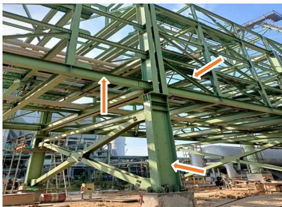
Gambar 3. Komponen dari pipe rack structure
