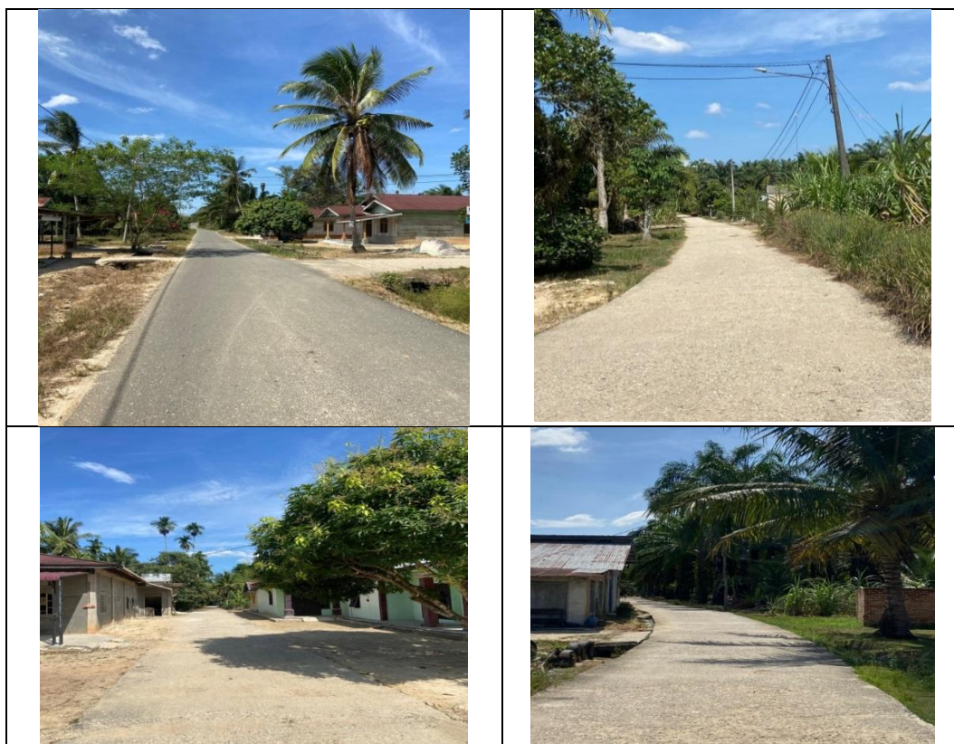
Gambar 5. Kondisi Jalan Desa Muara Basung yang Sudah Layak
