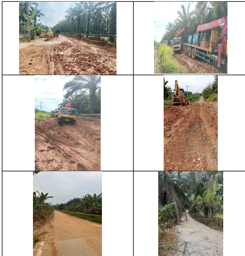
Gambar 4. Kondisi Jalan Desa Muara Basung yang Tidak Layak
