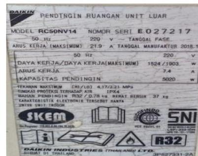
Gambar 4. Spesifikasi AC Daikin yang diuji
