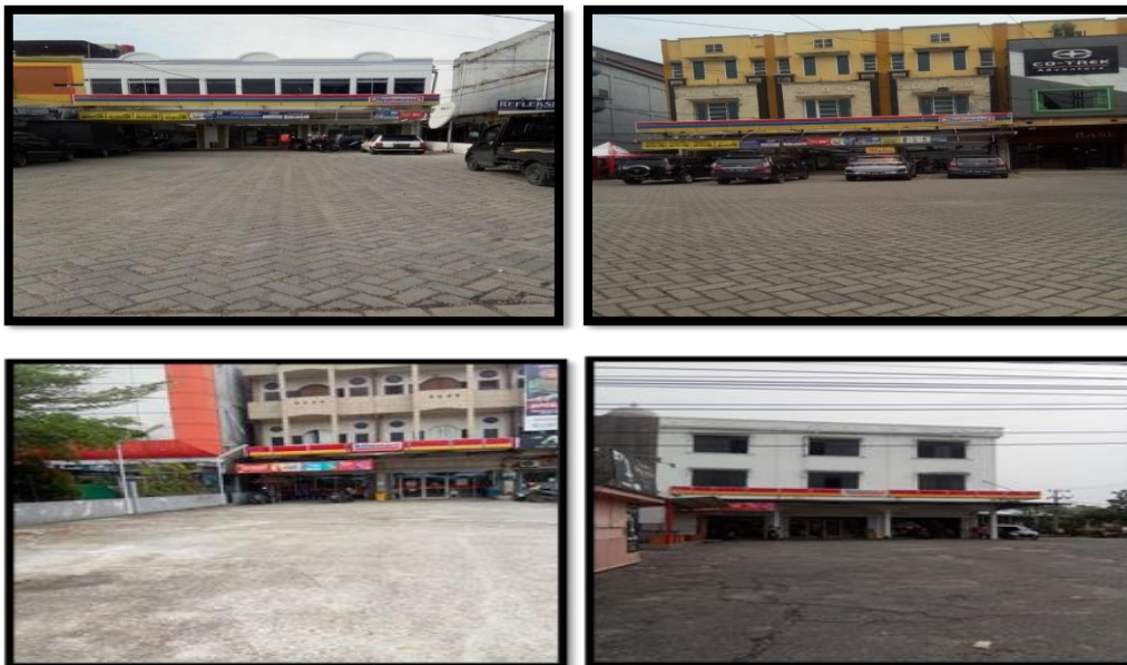
Gambar 1. Kondisi Eksisting Minimarket (Alfamart dan Indomaret) pada ruas Jalan HR.Soebrantas
