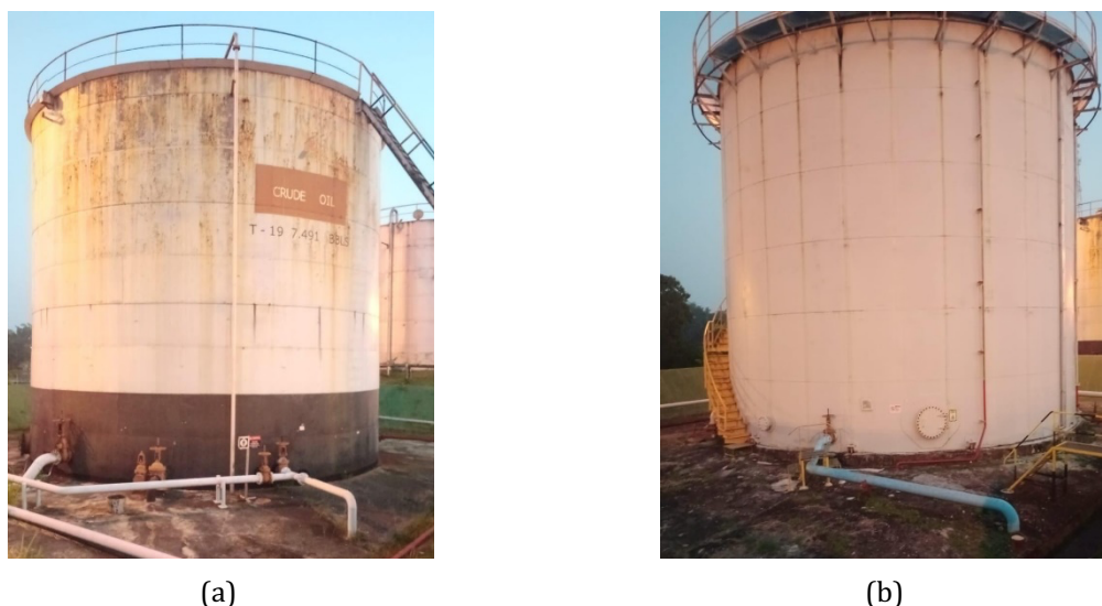
Figure 1. Tank Y (a) dan Tank Z (b) PT X Prabumulih
